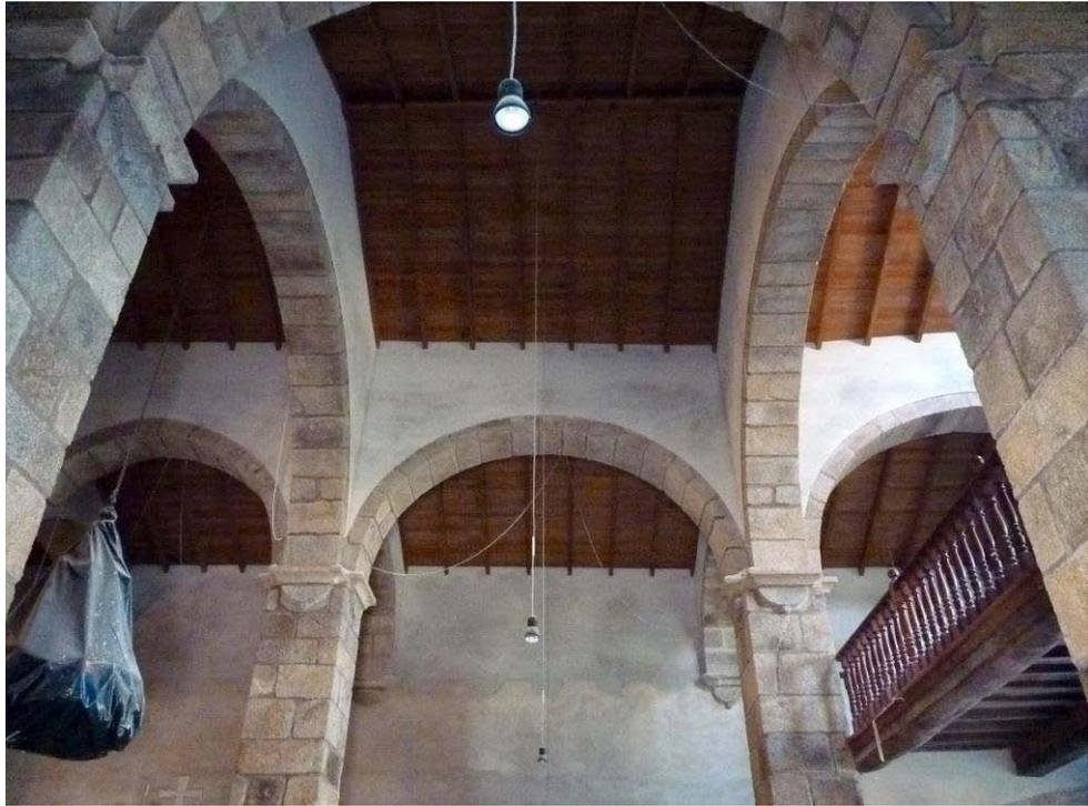
Foto n° 7: Vista de los arcos centrales con el nuevo revoco
