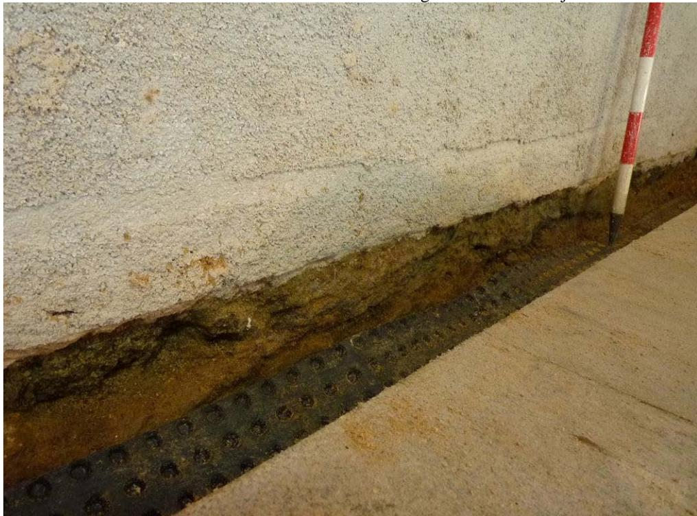
Foto nº10: Perfil tipo de la zanja de aireación perimetral
