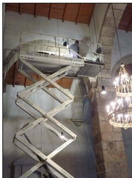
acabado raspado, y capa superior 1:4 con árido fino, repretado, aplicada a buena vista o pasteado con cal apagada y enlucido, según indicaciones de la D.F. y muestras previas realizadas en obra. Se aplicará coincidiendo con la estación seca de primavera o verano.
