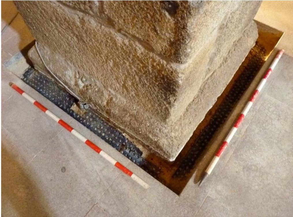
Foto nº 13: Ejemplo de zanja perimetral de aireación junto a los pilares
