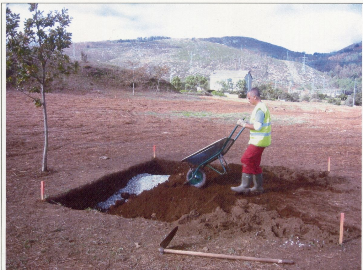
Tapado das sondaxes ao final da escavación
