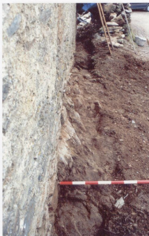
Zanja perimetral. Muro lateral pegado al camino de acceso.
