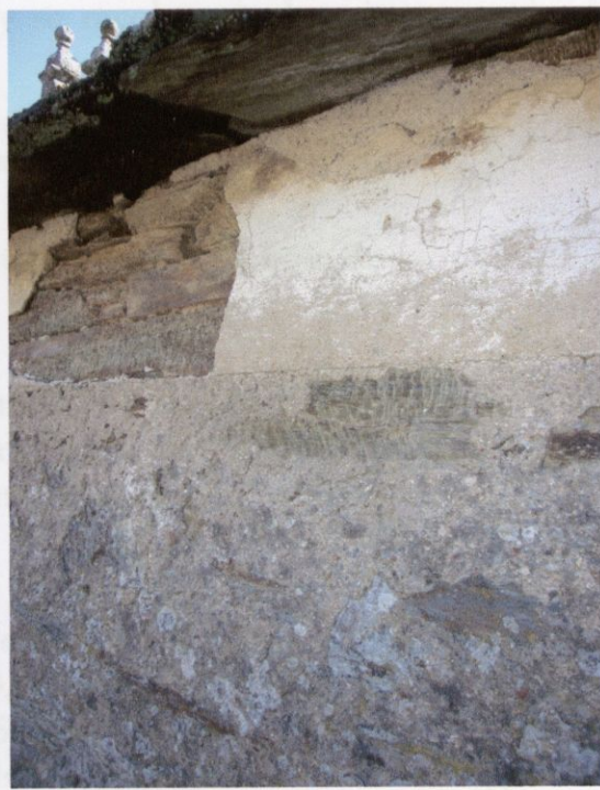
Detalle de las cales, en la parte superior de la capilla.
