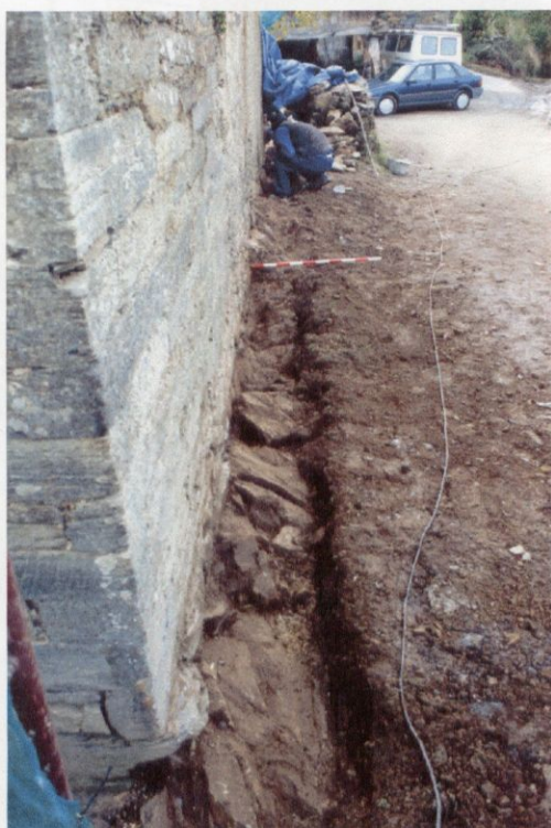
Zanja perimetral. Muro lateral pegado al camino de acceso.
