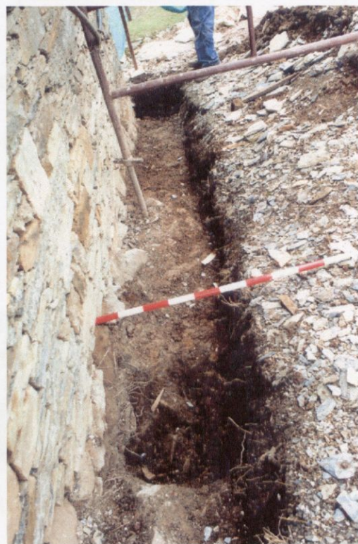
Zanja de drenaje. Cabecera de la capilla.
