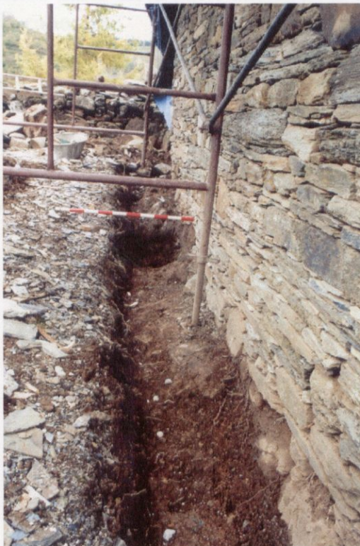
Zanja de drenaje. Cabecera de la capilla.
