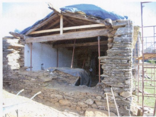
Desmontaje del muro de cabecera.
