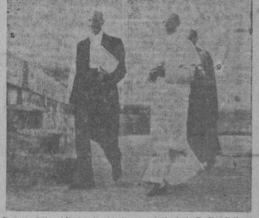
El Santo Padre visita las obras de la gran cúpula de la Basílica Vaticana (Foto OIPRA)
