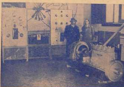
Grupo electrógeno construido en Talleres Pazó.
