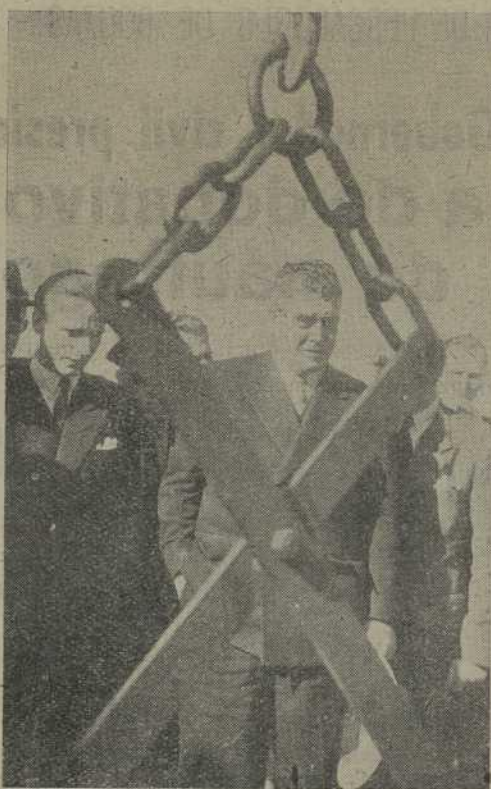
El Alcalde de Vigo presenciando la colocaci n de la primera piedra
