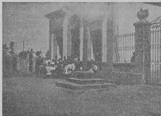
Colegio construido en Cornazo, a expensas de Don Agustín Romero García.
