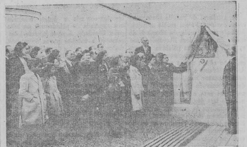
MOMENTO NO QUE o Presidente de Irmandade Galega descubre a Placa de bronce, colocada no edificio das Bodegas "La Superiora", como homaxe ao seu extinto fundador e presidente, don Manuel L. Lemos
