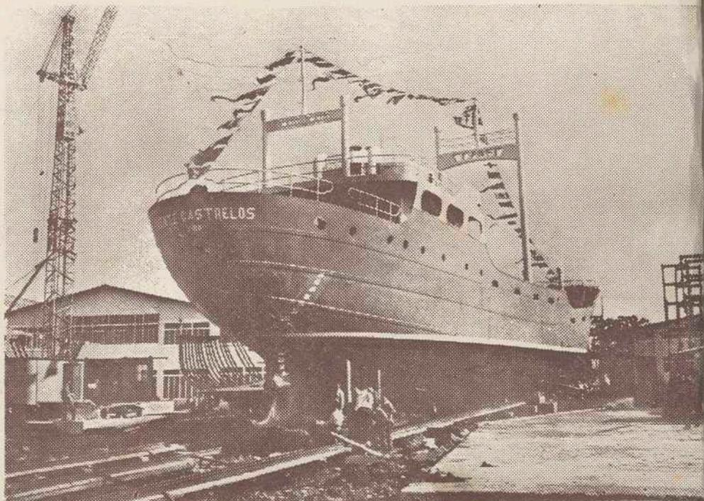
Los aspectos de la reciente botadura del vapor «PUENTE CASTRELOS», de 830 toneladas de desplazamiento y estructura totalmente metálica. Es una de las últimas naves construidas en estas Factorías.
