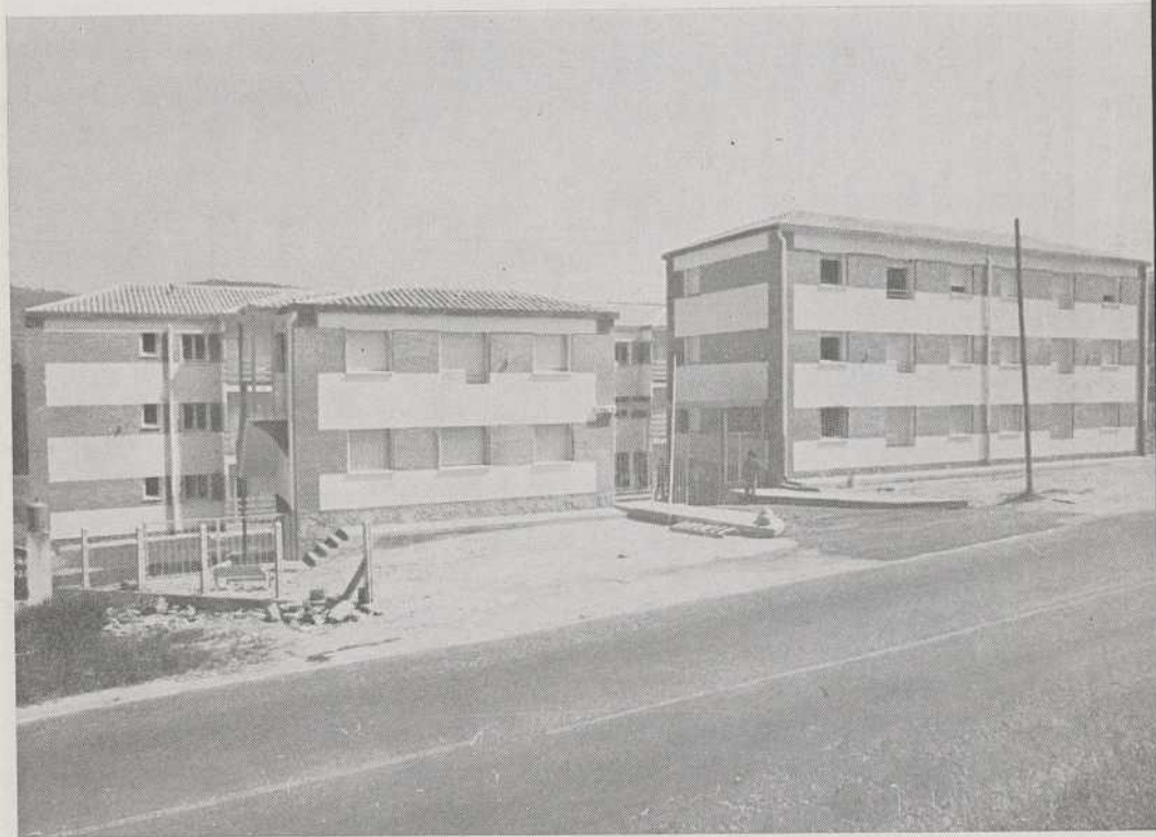
Nuevos edificios para la Casa Cuartel de la Guardia Civil de Puente deume, de inminente inauguración, situados en la carretera general Ferrol-Coruña.
