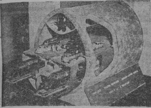
La construcción de un túnel que una a Inglaterra con Francia está de nuevo en candilero. Varios proyectos se han presentado. En la foto aparece la maqueta del ideado por el francés Basdevant. Tiene dos conductos de atracción y una doble vía férrea. En la parte central, una autopista, dividida por un andén para peatones (Foto Keystone.)
