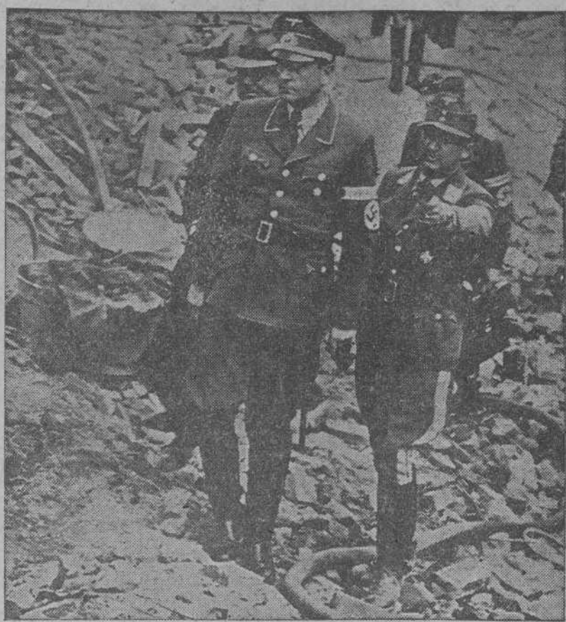
El ministro Speer, jefe de la Organización Todt, inspecciona las ruinas ocasionadas por un fuerte bombardeo británico contra una ciudad del Oeste de Alemania
