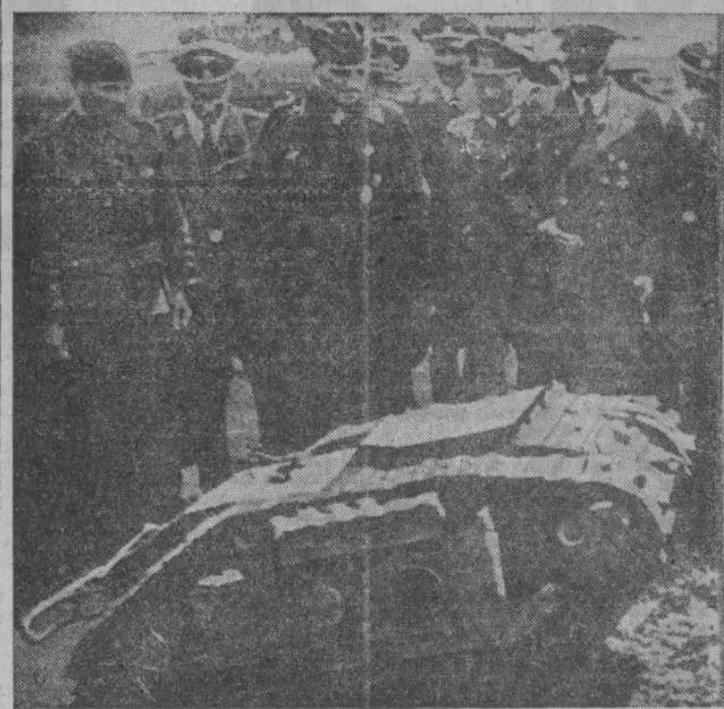
Esté tanque en miniatura ha sido usado por los alemanes en Rusia y en la cabeza de puente de Anzio. Sus dimensiones son casi las de un juguete. Va accionado por dos motores eléctricos, controlados por radio, y en su interior lleva una carga explosiva de mil libras, que puede inflamarse también automáticamente. Puede desarrollar una velocidad aproximada de 35 kilómetros por hora, variable según el terreno por donde actúe, y es lanzado en grandes cantidades contra las líneas enemigas.
