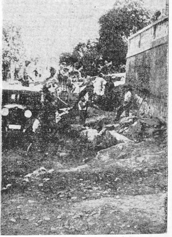
CORUNA.—Brigada de obreros que trabajan actualmente en el desmonte y explanación de la calle que enlaza la Atocha Alta con la calle de Orillamar. (Foto Artás).
