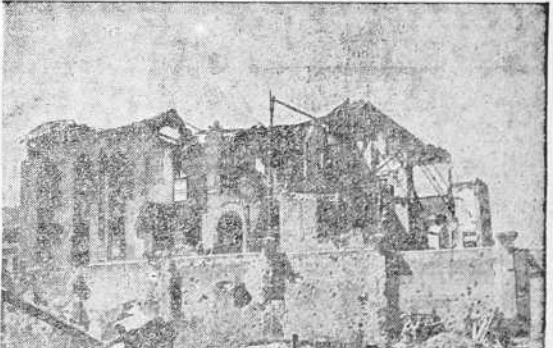
Estado de uno de los pabellones del Hospital-Manicomio
