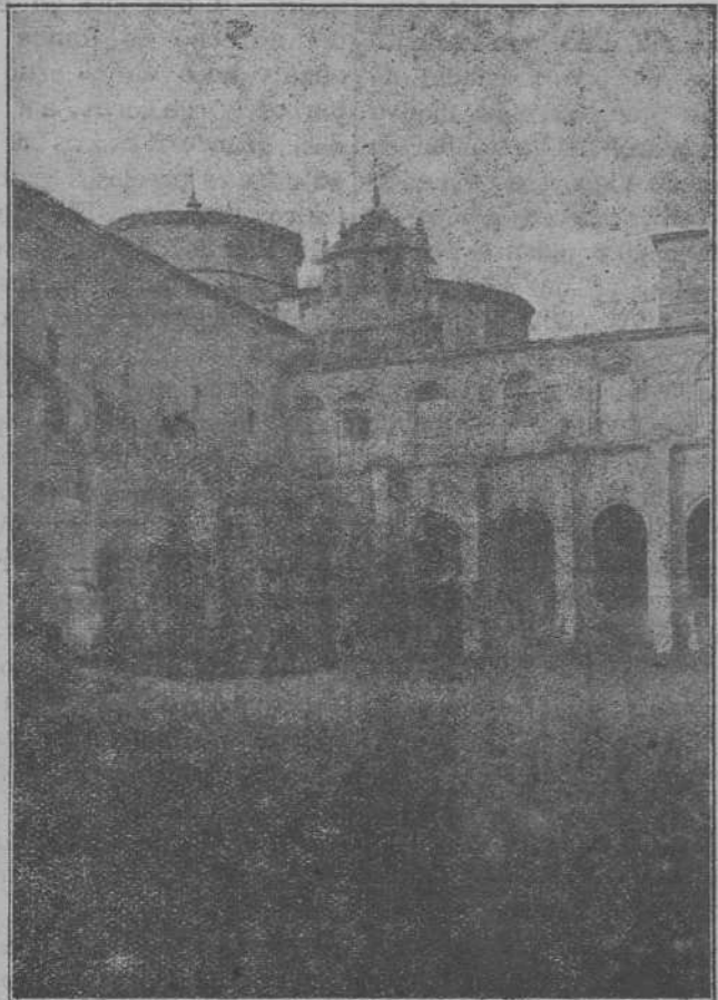
Patio de los pináculos, que se trata de convertir en habitaciones para el Parador del Patronato del Turismo.
