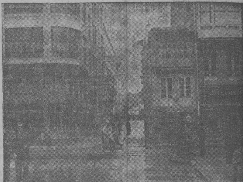
La célebre casa núm. 100 de la calle de San Andrés, uno de los auténticos edificios, para cuya desaparición se afía la piqueta municipal
