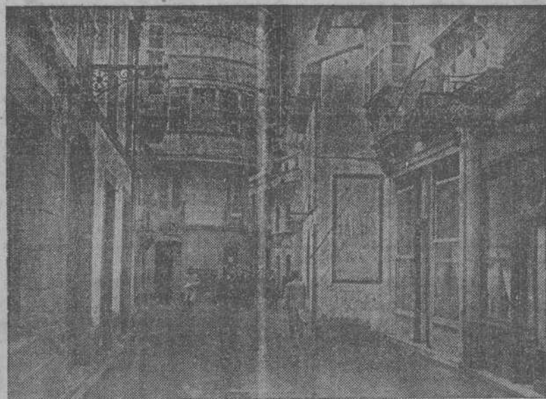
Saliente de la calle de la Galera, también condenado a desaparecer
