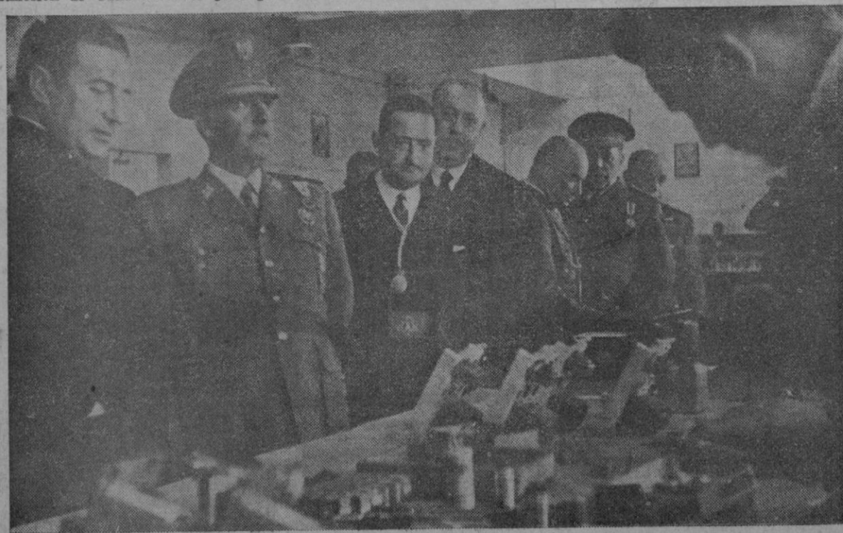
Francisco presencia el trabajo de un obrero en la fábrica de la F. E. N. Y. A., en la que se construye material telefónico y diversas instalaciones eléctricas.
