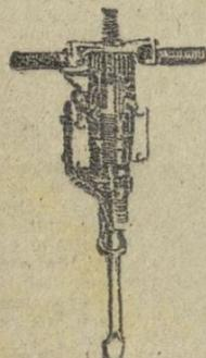
Pueden trabajar los martillos rompe-pavimentos, ingleses, marca PEGSON, accionados por motor de gasolina, directamente acoplado.
