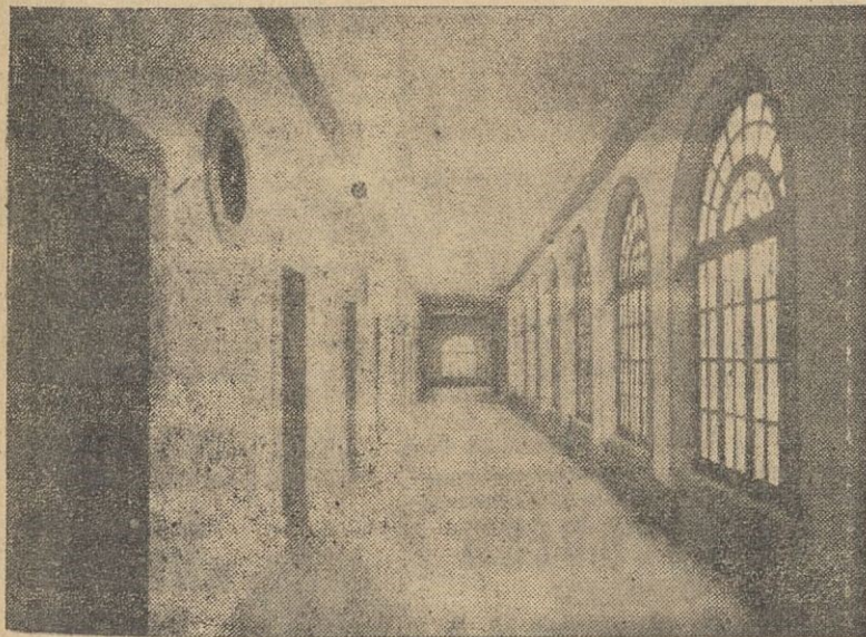
ASPECTO DE UNO DE LOS PASILLOS DE ACCESO A LAS CELDAS (Foto Arturo)
