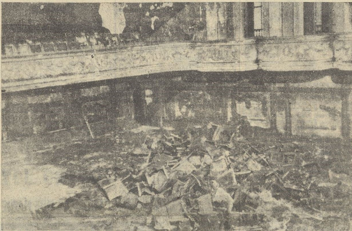
Esto fué el patio de butacas del Teatro Colón. Sobre el piso de cemento—el maderamen del suelo también quedó carbonizado—se amontonan los restos calcinados de las butacas, caídas ya del piso superior, también grandemente afectado. Los palcos del lado impar sufrieron también los efectos de las llamas. El aspecto, como se ve, es desolador.
