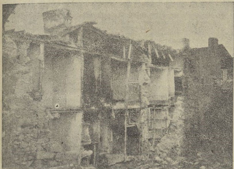
Un detalle de las casas derrumbadas, en donde puede apreciarse la magnitud del hundimiento.
