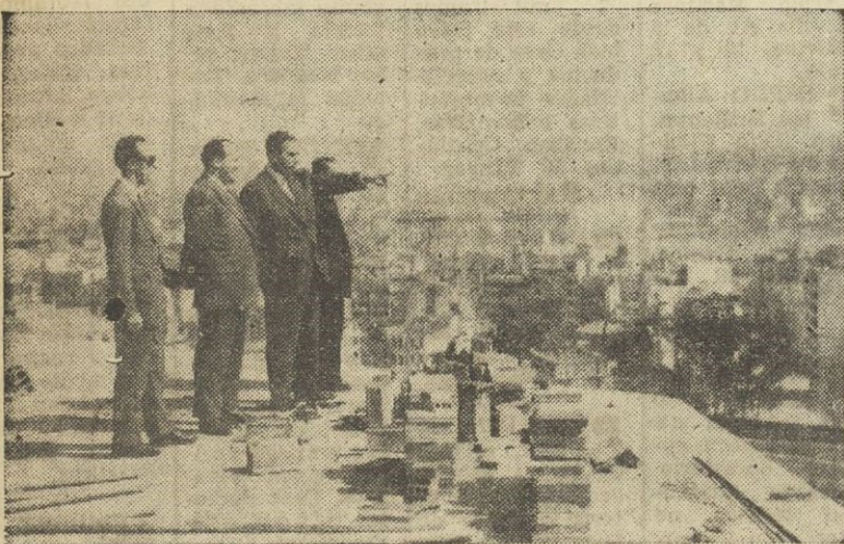
En el Parque de Joaquín Costa. Desde lo alto del palacete, se divisa una magnífica vista panorámica
