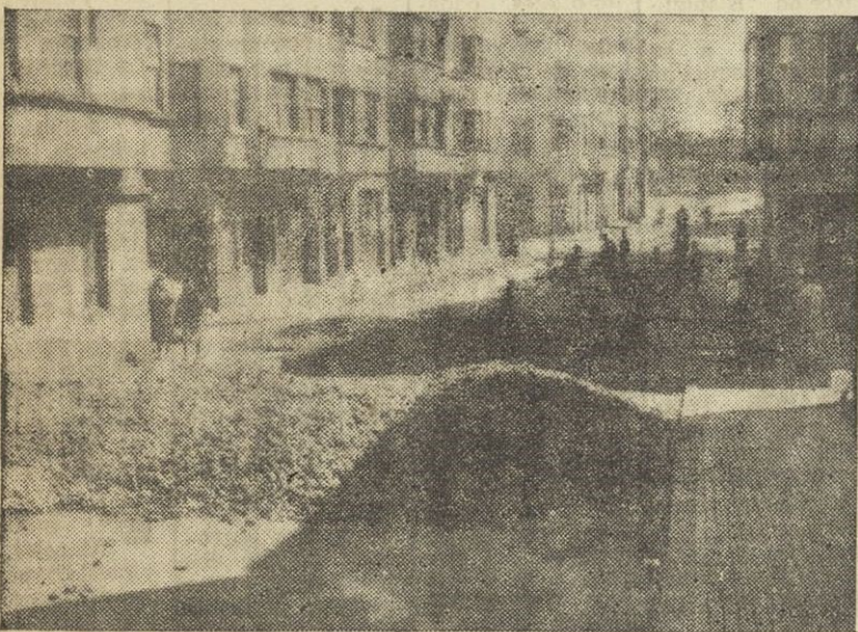
La avenida de Noya, en la cual se procede a su pavimentación de cemento
