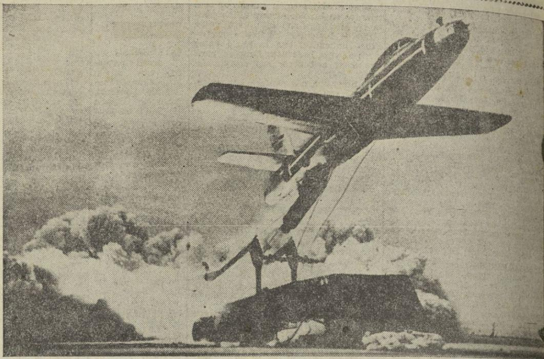
Un avión americano a reacción despegó de la plataforma de un gran camión, convertida en aeródromo individual, durante unas pruebas efectuadas en California, para el despegue con el auxilio de unas botellas propulsivas de gran potencia, que hacen innecesarias las grandes pistas corrientes
