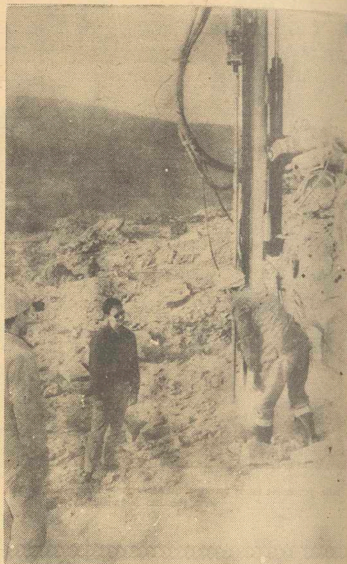
Perforando la montaña. Este mecanismo logra un taladrado de seis metros en menos de cinco minutos.
