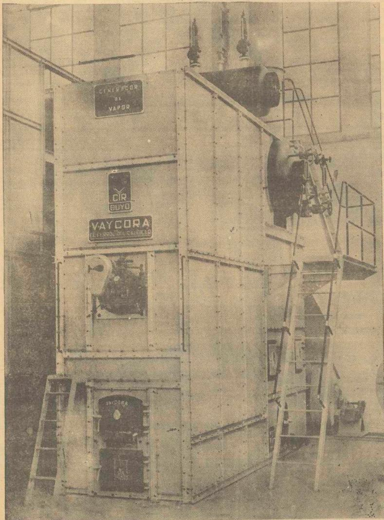
Generador de vapor de 2.000 Kg./h a 15 Kg/cm.2. Combustión mixta. Desperdicios de madera y fuel-oil. Instalada en VIUDA DE AVELINO SAN LUIS. Santiago de Compostela.
