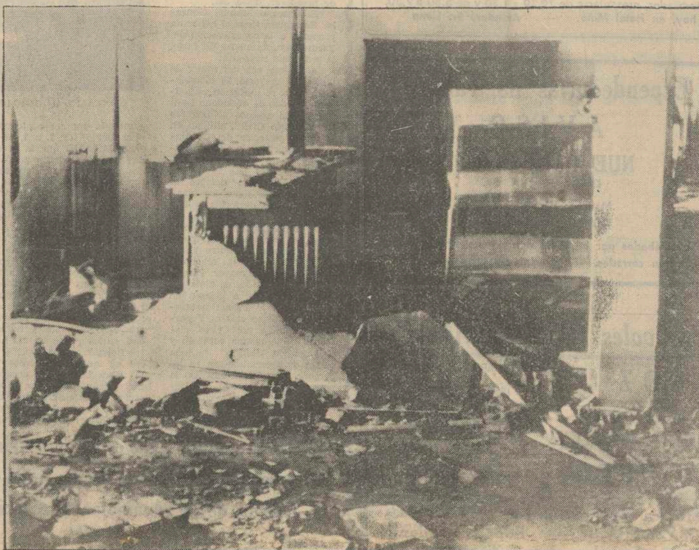
En esta fotografía aparecen los destrozos ocasionados en una de las dependencias del Palacio de Justicia de Pontevedra en donde hizo explosión un artefacto colocado en una de las ventanas de la planta baja. El hecho ocurrió la misma noche en que actos similares tuvieron lugar en Madrid, Barcelona, Bilbao y Sevilla. (Foto Cifra Gráfica)
