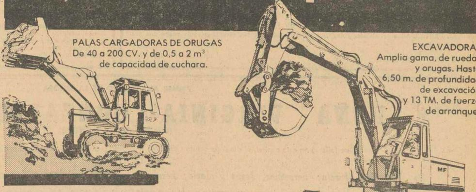
PALAS CARGADORAS DE ORUGAS De 40 a 200 CV. y de 0,5 a 2 m<sup>3</sup> de capacidad de cuchara.
