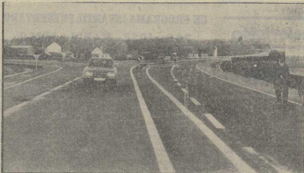
En la tarde de ayer quedó abierto al tráfico el nuevo puente sobre el río Miño y los accesos de la N-VI a su paso por Rábade. La longitud total de las obras inauguradas es de mil quinientos ochenta metros y el total invertido en ellas se eleva a setenta y dos millones ciento diecinueve mil pesetas. En la fotografía de Vega puede verse una vista de los accesos que ayer fueron puestos en funcionamiento
