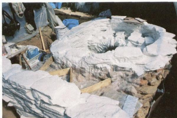
entre la cámara y la boca de carga se rellenó con poliestireno reforzado por listras de madera.
