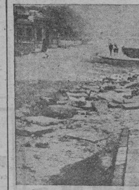
En estos días ha azotado un fuerte temporal a una gran parte de la costa del Cantábrico. San Sebastián ha sufrido, como siempre y con mayor dureza, las embates del mar, castigando duramente la cornisa del Paseo Nuevo, llegando incluso a desmenuarse parte del pavimento y las aceras, rompiendo sus gruesas y grandes losas de piedra.
