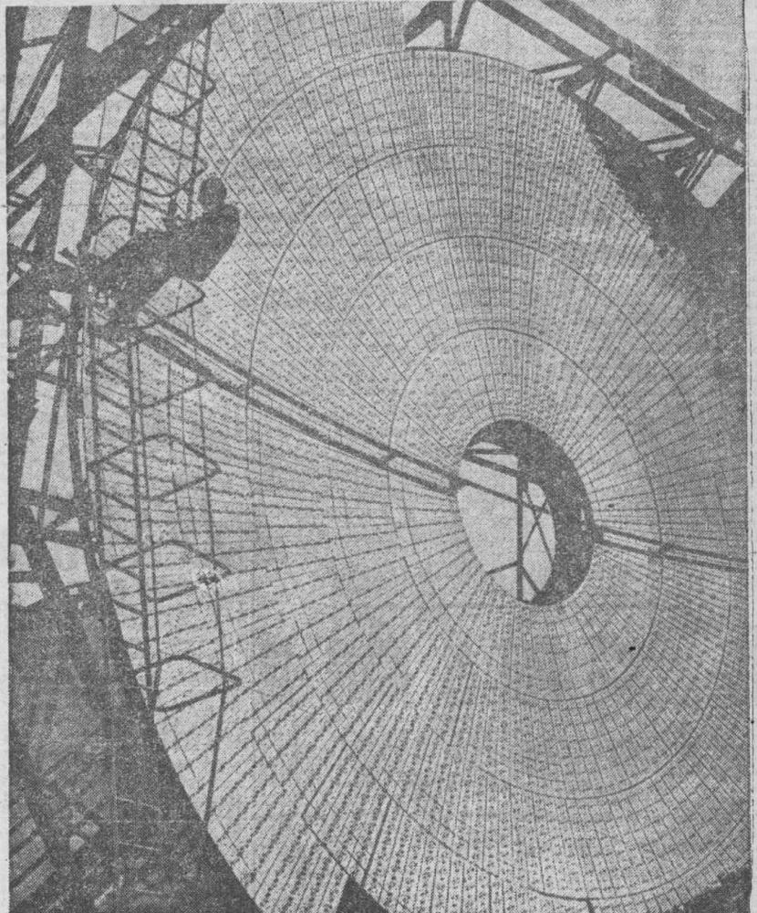
El espejo parabolico que el profesor Trombe ha instalado en un lugar de los Pirineos para captar y aprovechar la energía solar
