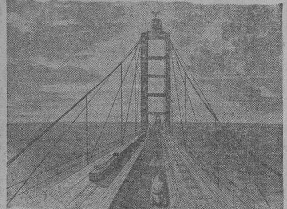
Un aspecto del proyecto del puente, visto de frente, mostrando la doble vía del ferrocarril y la carretera central
