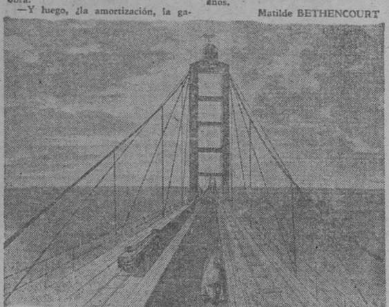
Un aspecto del proyecto del puente, visto de frente, mostrando la doble vía del ferrocarril y la carretera central
