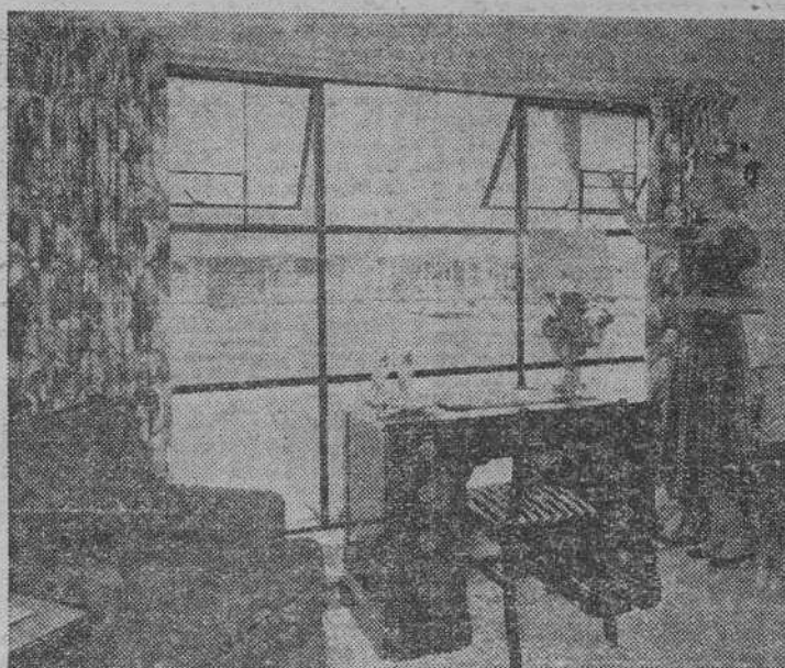
Gran ventana metálica. Sus diferentes cuarteles —de los cuales los superiores están destinados a la ventilación— constituyen un elemento decorativo, de acuerdo con el estilo de la casa
