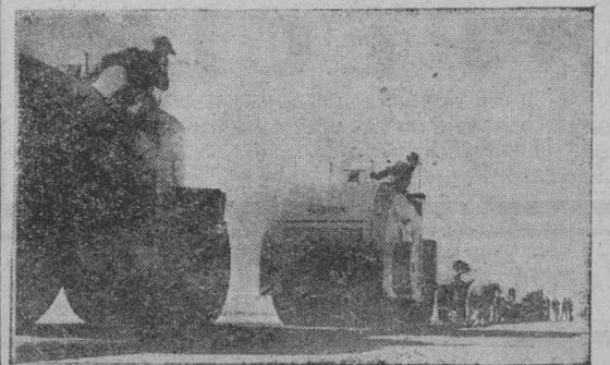
Después de derramar asfalto sobre las pistas, estas potentes apisonadoras nivellan las superficies de las mismas en el aeródromo de Torrejón de Ardoz.
