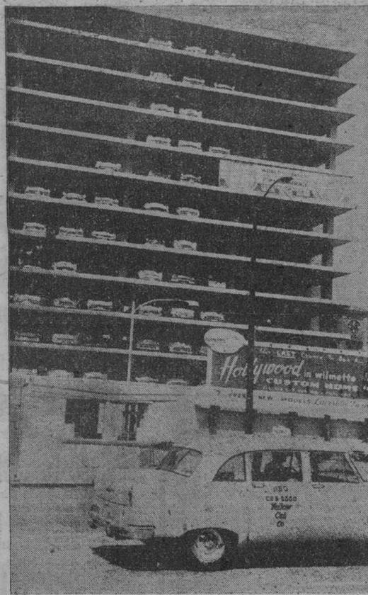
Para descongestionar el aparcamiento callejero se ha construido en Chicago este curioso edificio. Los coches pueden salir y entrar en el garaje con gran rapidez, mediante un sistema de ascensores y rampas.
