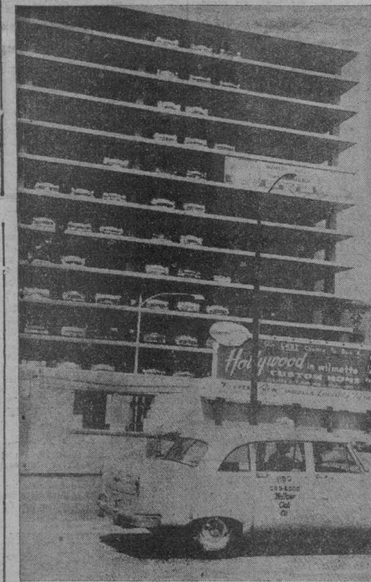
Para descongestionar el aparcamiento callejero se ha construido en Chicago este curioso edificio. Los coches pueden salir y entrar en el garaje con gran rapidez, mediante un sistema de ascensores y rampas
