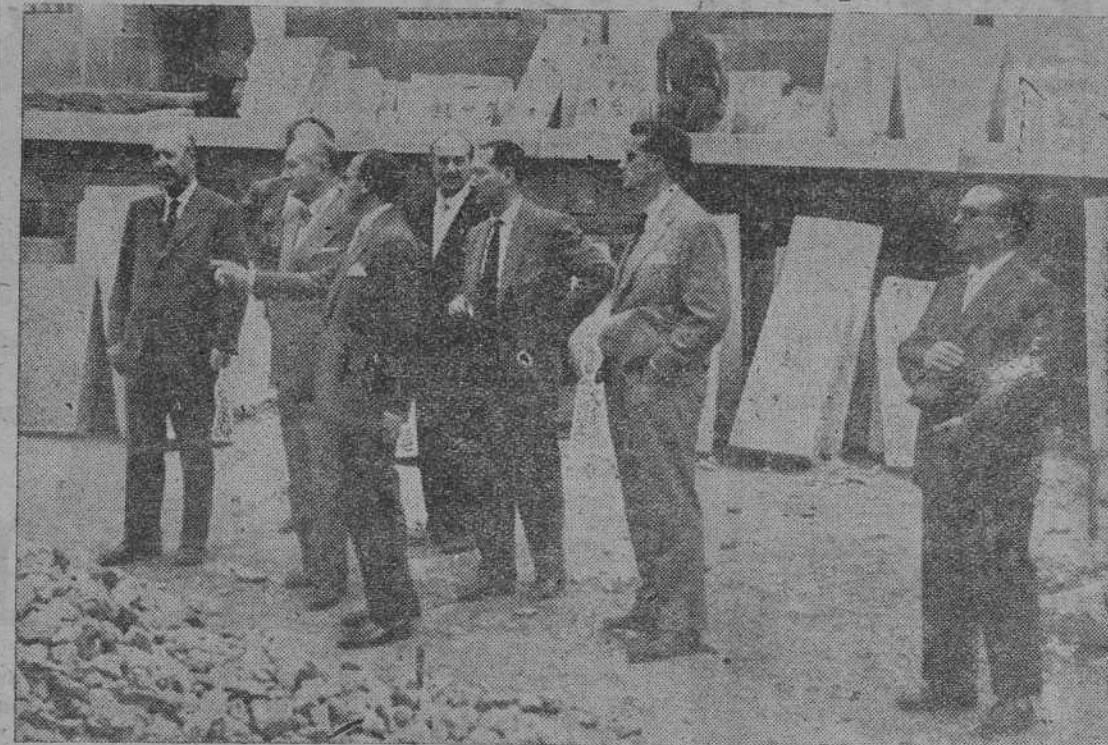
El Ministro de la Vivienda inspectando las obras que se realizan en la Plazuela de San Martín (Foto Arturo)
