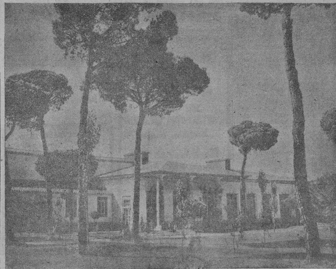
Un detalle del albergue de turismo de Tordesillas que inauguró por el Caudillo de España. Está situado en la carretera de Valladolid a Salamanca, a 400 metros del cruce con la carretera de Madrid a La Coruña
