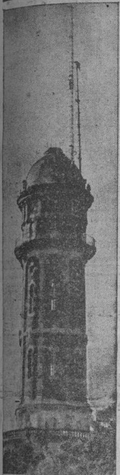
En la cúpula de la Torre de las Aguas del Tibidabo ha sido colocada la antena de la emisora barcelonesa de Televisión Española. En el grabado, el final de la primera fase: junto a la "pluma" de ascensión (estructura metálica de la izquierda, más alta), la antena "supertunstyle", de 23 metros, que poco después fue ajustada en el centro de la cúpula. La operación fue difícil, pero felizmente llevada a término.
