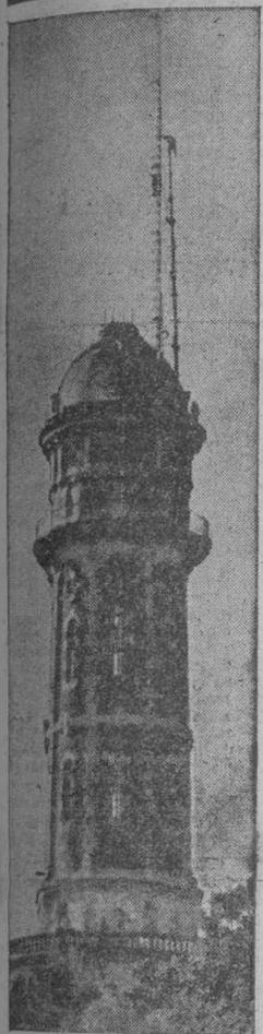
En la cúpula de la Torre de las Aguas del Tibidabo ha sido colocada la antena de la emisora barcelonesa de Televisión Española. En el grabado, el final de la primera fase: junto a la "pluma" de ascensión (estructura metálica de la izquierda, más alta), de 23 metros, que poco después fue ajustada en el centro de la cúpula. La operación fue difícil, pero felizmente llevada a término.
