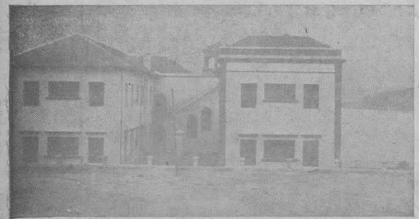
Edificio del Cuartel de marinería en el recinto de la Escuela Naval Militar de Marín
