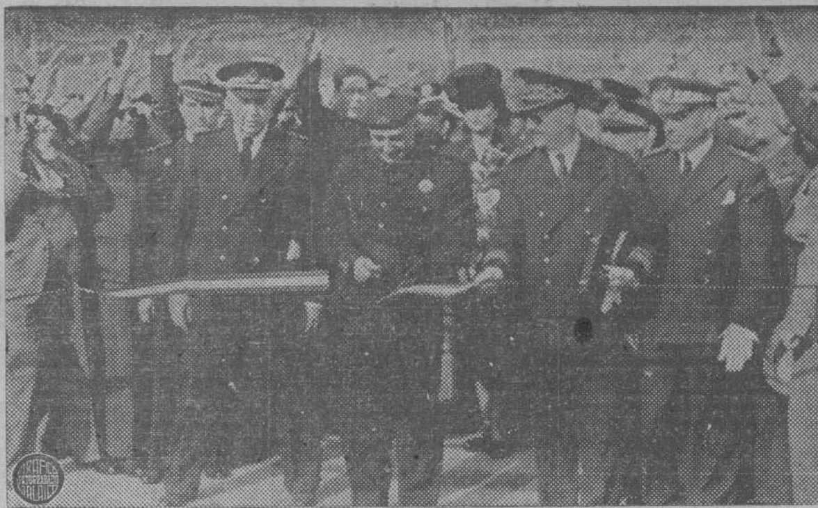
EL CAUDILLO EN EL PRECISO MOMENTO DE CORTAR LA CINTA SIMBOLICA QUE ABRIA A LA CIRCULACION EL PUENTE DEL PEDRIDO, INAUGURADO EN ABRIL DE 1943
