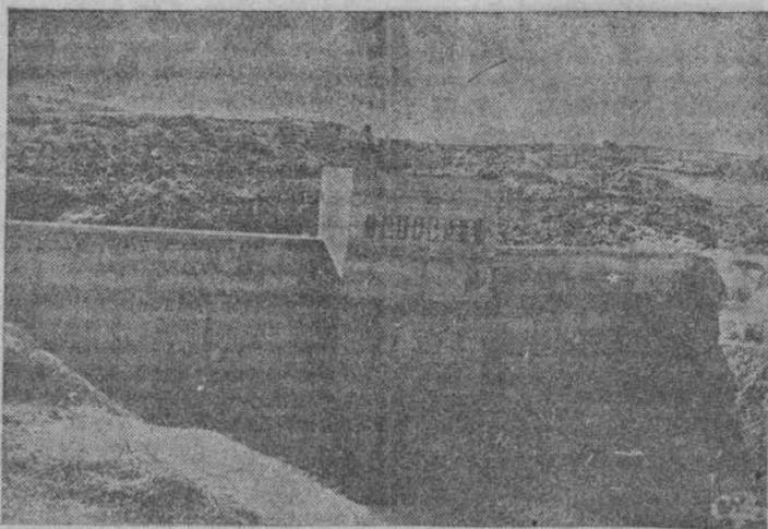
El paramento de aguas de la presa del Esla, de 99 metros de altura, en que se aprecia al descubierto los ventanales de la toma de aguas.—(Foto GFFRA).
