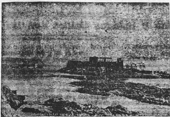
He ahí el Canal en baja mar. Las peñas que sobresalen del agua están indicando que existe ya en gran parte una magnífica cimentación natural para el dique, el día que el Estado se decida a construirlo. (Foto "El Ideal Gallego")
