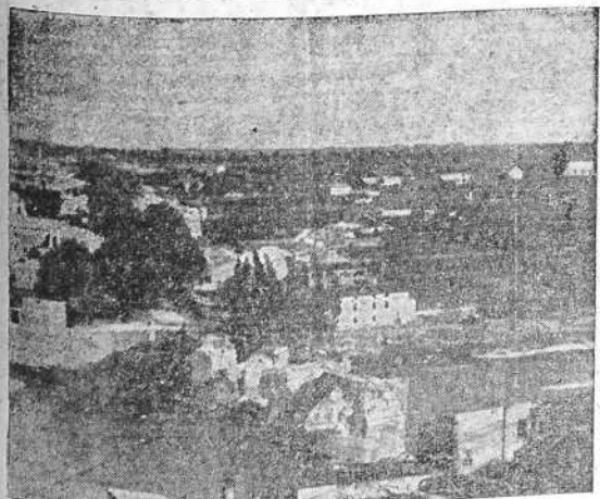
Vista panorámica de la famosa cabeza de puente de Balaguer atacada furiosamente por los rojos y que, pese al lujo de elementos materiales y mandos rusos y franceses con que cuentan, no lograron avanzar ni un solo metro sobre el terreno. En primer plano el puente sobre el río Segre, puente destruido por los marxistas. (Foto Dumas)
