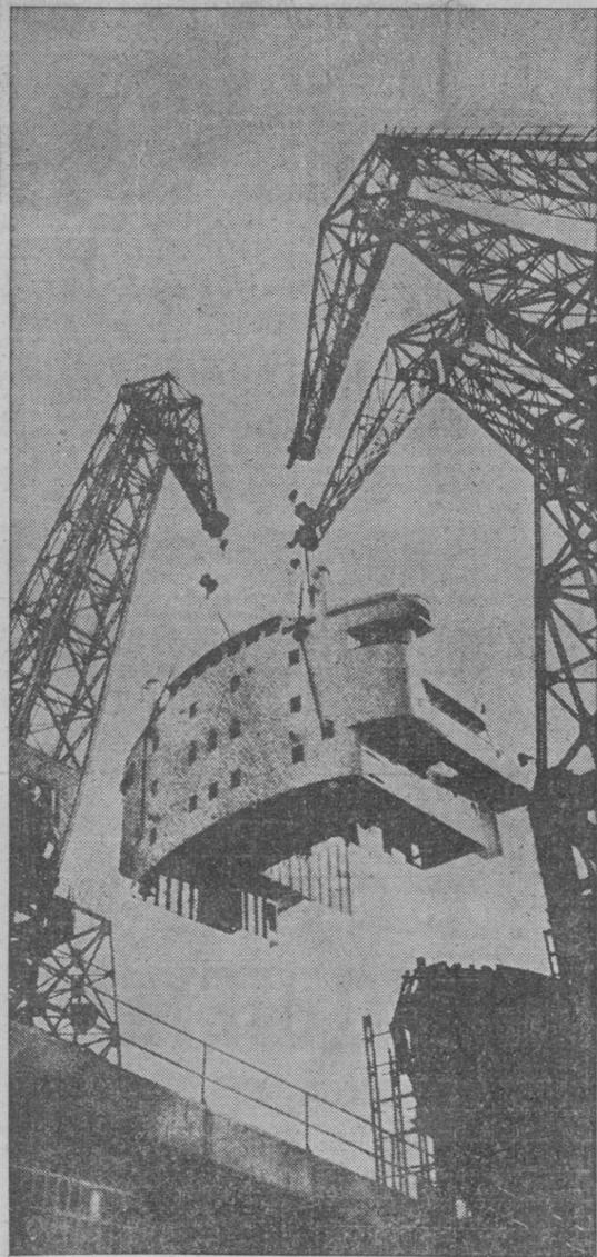
**BILBAO. —**Tres enormes grúas —las mayores fabricadas en España—, con una potencia por unidad de 40 toneladas y con un alcance y altura de 40 y 65 metros respectivamente, proceden a colocar sobre el casco de un buque el puente completo prefabricado, con un peso total de 135 toneladas. Esta maniobra, fuertemente realizada, constituye un avance técnico de primer orden para los astilleros españoles, y supone una verdadera revolución en los medios de construcción de barcos.
