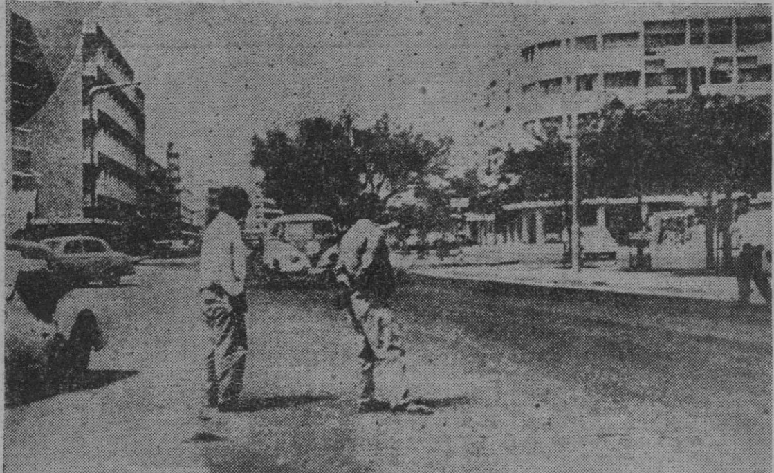
KUWAIT. — El centro de los negocios del mercado petrolífero, con ultramodernos edificios, anchos pavimentos y árboles de espesas ramas que crecen en lo que fue terreno desértico.
